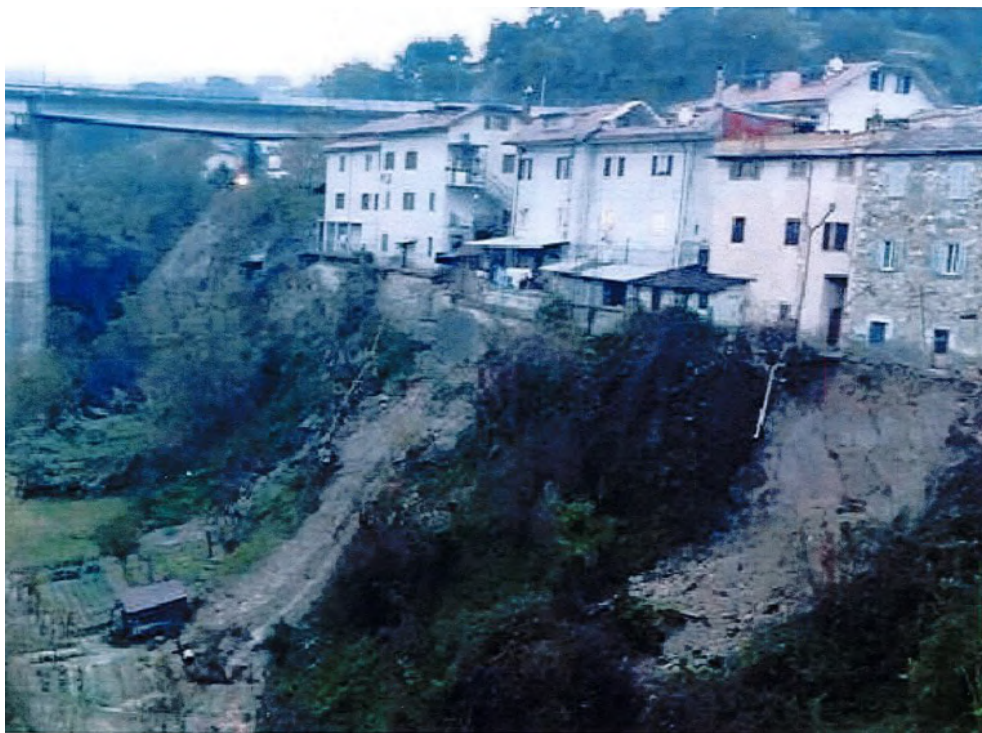
Fig. 8 - Foto del versante dal ponte di S. Chiara, con evidenza dei fenomeni gravitativi causati dall'evento meteorologico del 2013.
